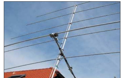
Bild 2: Montage des Rotary-Dipols oberhalb der LP7, Mast gekippt Fotos: DL7VEE
